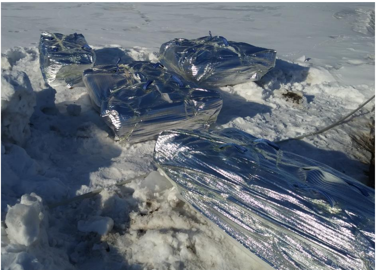
Рисунок 25 и 26 Процесс замотывания ледяных блоков теплоизоляционным материалом
