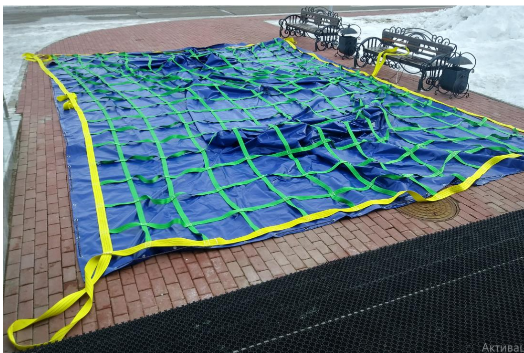
Рисунок 2 и 3 Проверка и раскладка водонепроницаемого подлога и нагрузочной сетки
